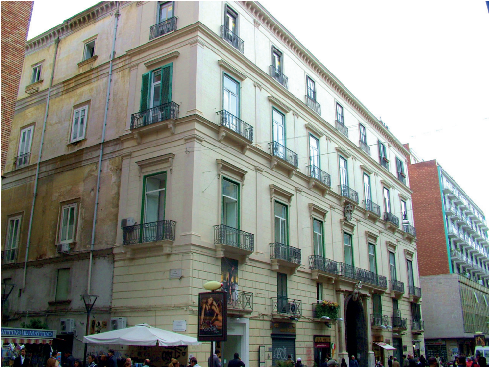
11. Napoli, palazzo di Tocco a via Toledo (Foto dell'autore).
