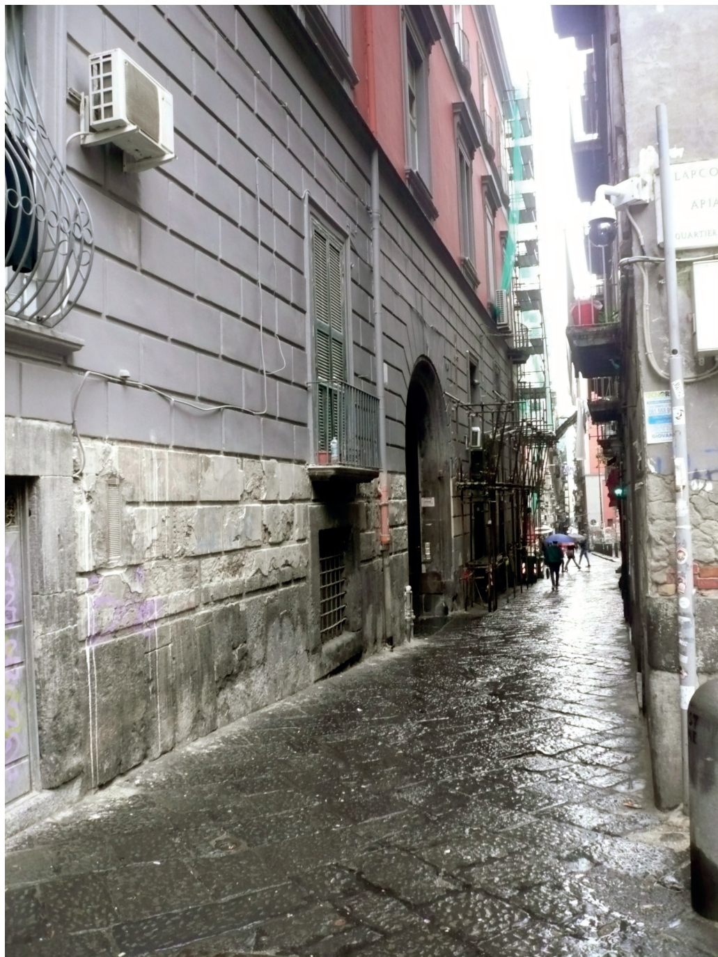
2. Napoli, palazzo di Tocco a via Atri, facciata principale (Foto dell'autore).
