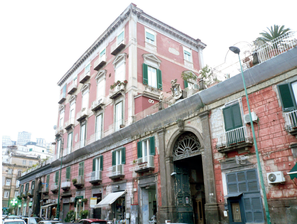
8. Napoli, palazzo di Tocco a corso Vittorio Emanuele (Foto dell'autore).
