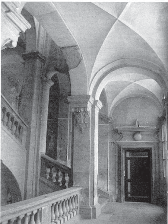
10-13. Napoli, palazzo Caracciolo d'Avellino, facciata della scala sul cortile e particolari.
